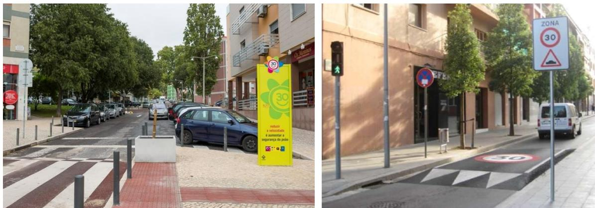
**Figura 152 - Zonas 30, com lombas de redução de velocidade**
